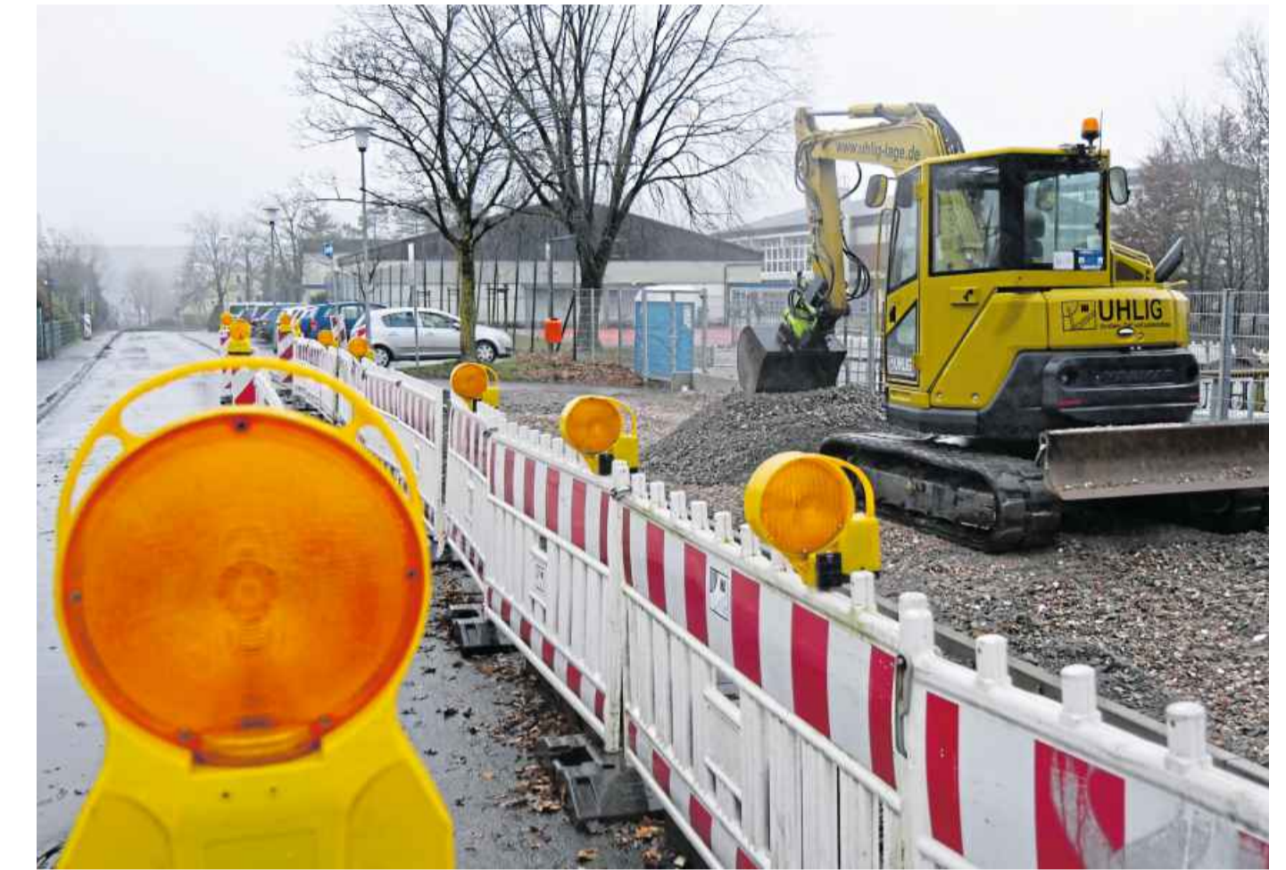
Muss die Gemeinde bezahlen: Arbeiten an den Parkplätzen der Augustdorfer Grundschule „In der Senne“ im November 2021.
