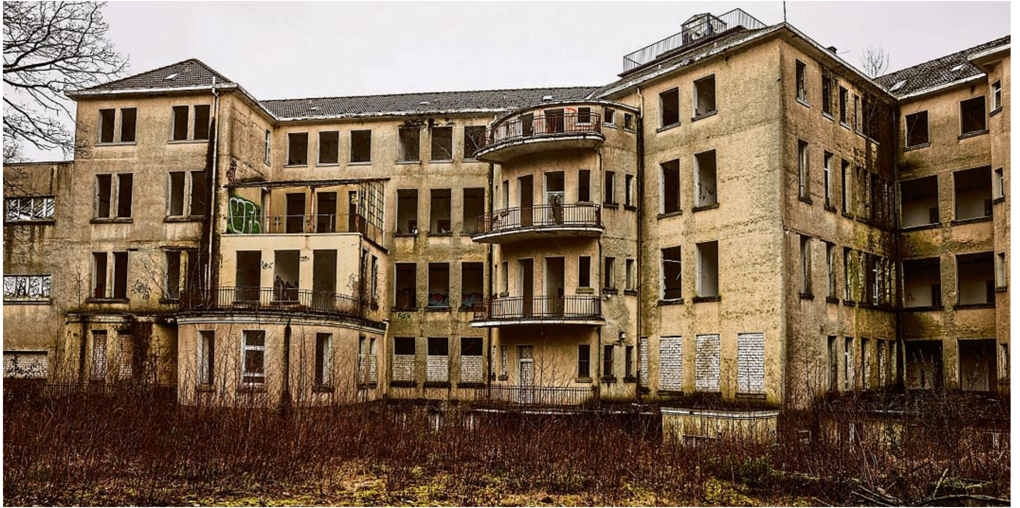
Inzwischen eine Bauruine: Das Hauptgebäude der ehemaligen Klinik Aprath. Im Jahr 1961 verbrachten die Geschwister Rita und Werner Breuer aus Eiserfey, damals gerade vier und sechs Jahre alt, rund ein halbes Jahr in der Einrichtung in Wülfrath. Foto: dpa/Oliver Berg
